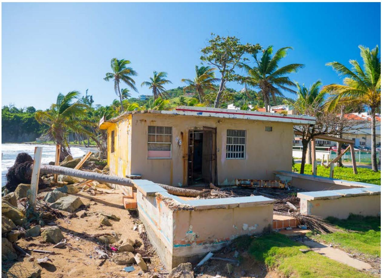
**Figura 16** Erosión catastrófica y daños a las infraestructuras en Puerto Rico a causa del huracán María
